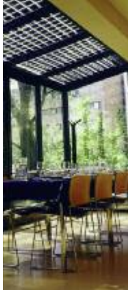
▲ Semi-transparante integratie, Cafeteria Imec, 2 kWp, 2000
